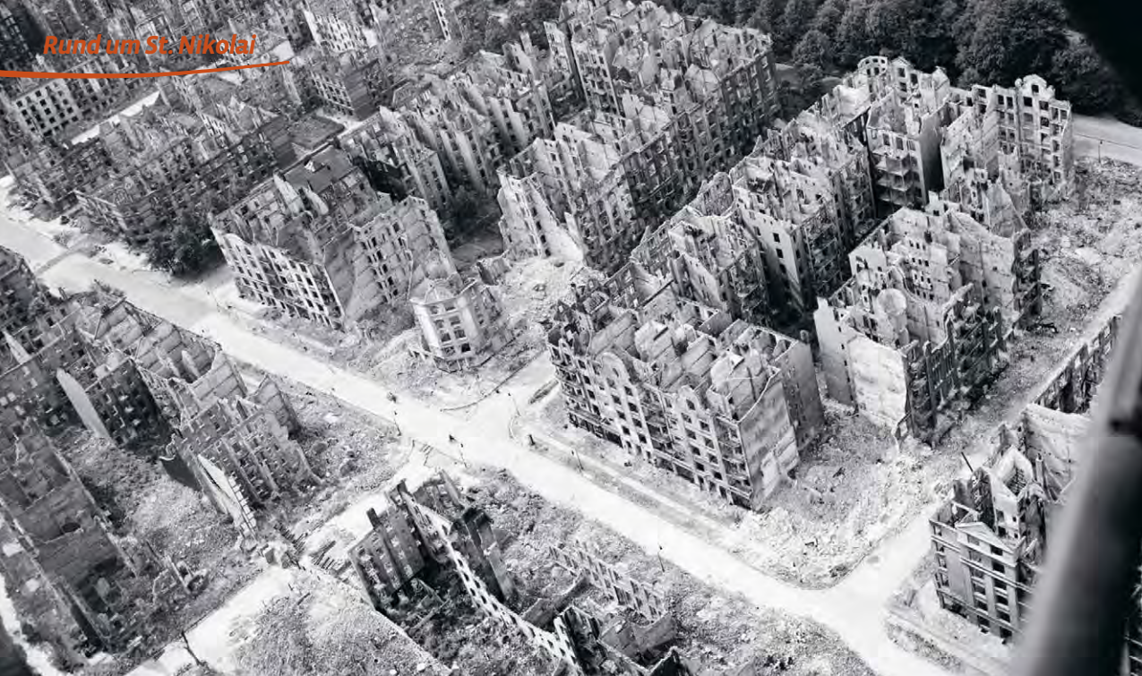
Hamburg, Eilbeker Weg, nach den Bombenangriffen der „Operation Gomorrha“
